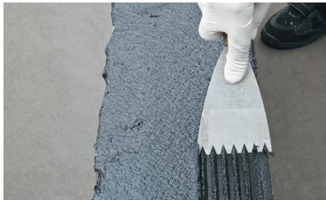
Enkolit® mit dem Rillenspachtel abziehen
